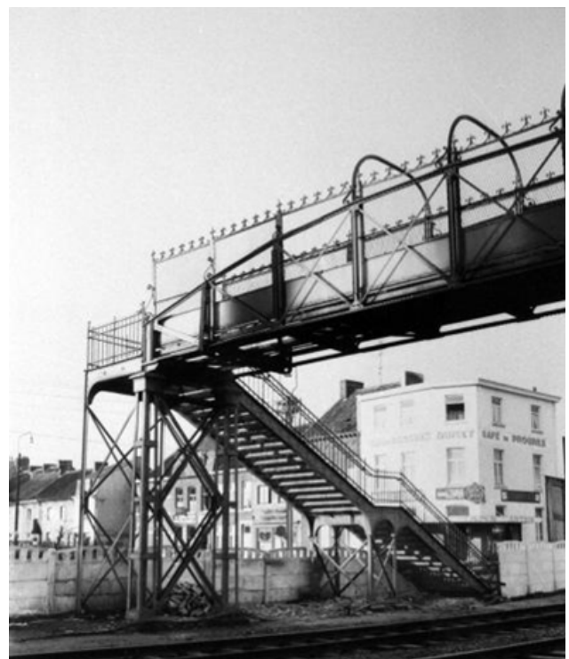
Passerelle over de sporen
