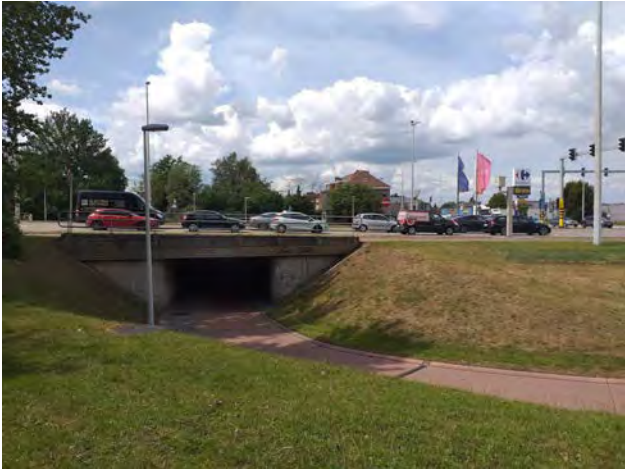
Tunnel onder de Singel
