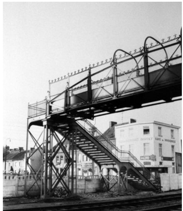
Passerelle over de sporen
